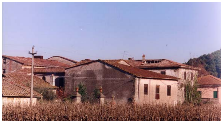
Casa Piaggia a Badia di Cantignano (Lucca), come appare oggi. Foto dell'autore.
